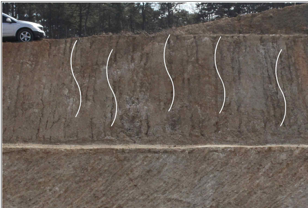
【그림 7】 A 영역에서 관찰된 토사유실 및 우류침식
