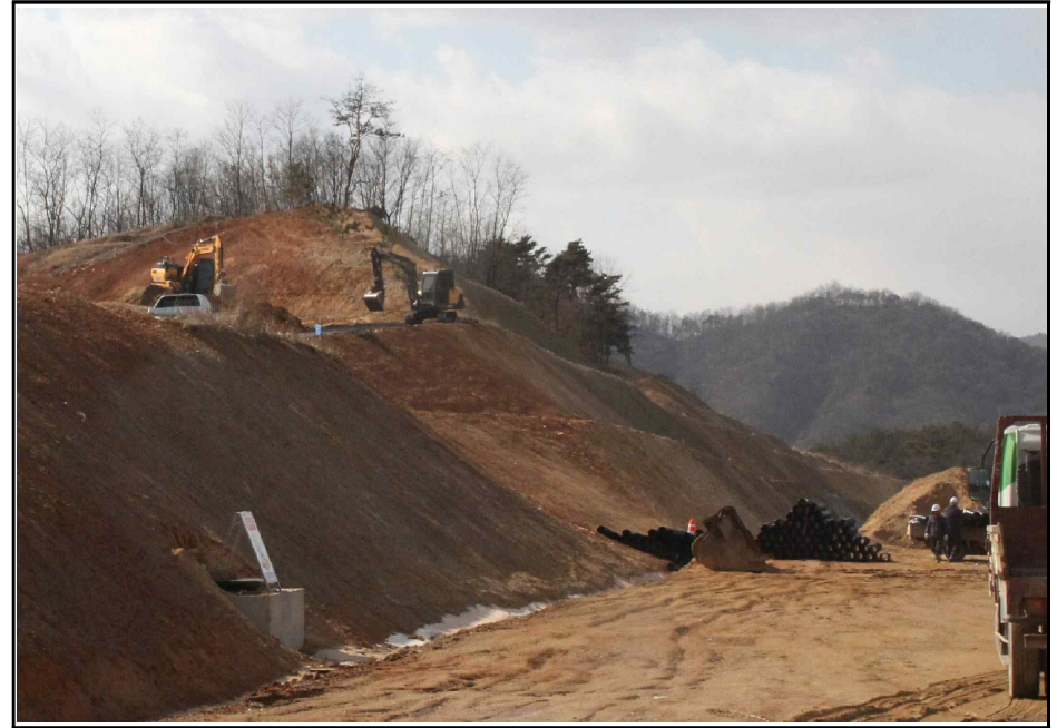
【그림 4】 깎기비탈면 종점부 측면 사진
