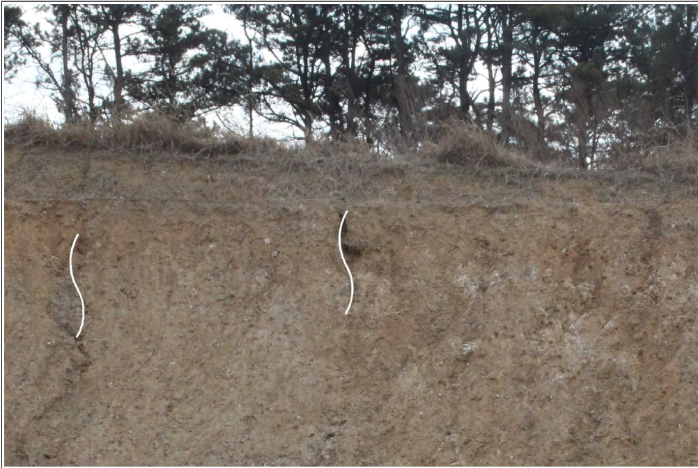
【그림 24】 E 영역에서 관찰된 토사유실 및 우류침식
